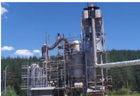
Газификационна система за третиране на отпадна дървесина и паралелно генериране на ел.енергия и гореща вода, функционираща в община Доспат
