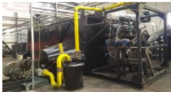
Пиролизна система за третиране на ТБО и паралелно генериране на ел.енергия и гореща вода, функционираща на сметището на община Созопол
