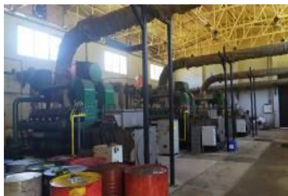
Газификационна система за третиране на отпадна дървесина и паралелно генериране на ел.енергия и гореща вода, функционираща в община Доспат
